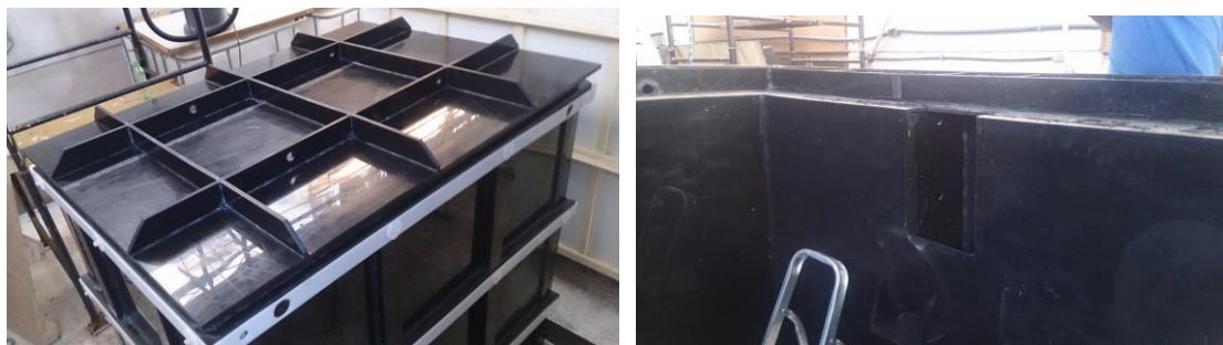
Figura 52. Esquerda: nova tampa do Target , fechando-o. Direita: “caverna” no Shielding .
