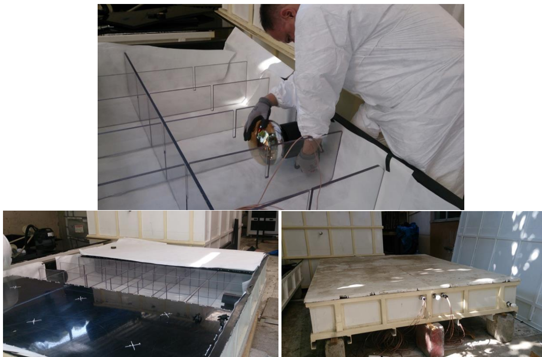
Figura 54. Acima: instalação de PMT no veto inferior. Abaixo, a esquerda: veto inferior com destaque para o engradado de policarbonato. Abaixo, a direita: veto inferior fechado após instrumentação.
