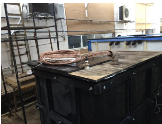
Figura 49. Tampa provisória de madeira do Target , fechando-o.
