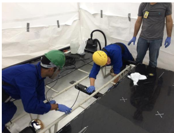
Figura 67. Montagem do veto superior na usina Angra II.
