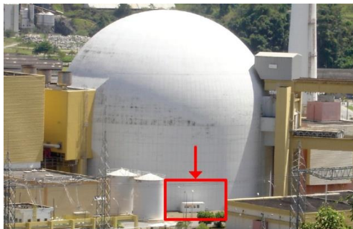
Figura 16 - Container do detector de neutrinos na usina nuclear de Angra II [17].
