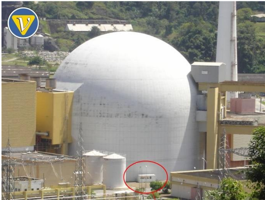
Figura 4.2: Contêiner instalado a cerca de 25 m do núcleo do reator nuclear de Angra II.
