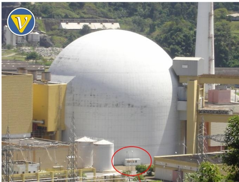
Figura 4.4 – Contêiner instalado ao lado da contenção de concreto do reator de ANGRA II
